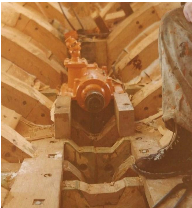
Propellern och reverseringsmekanismen monterad.
